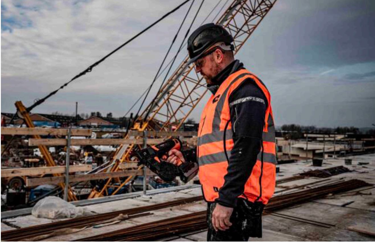
TJEP sidujate üks peamisi eeliseid on see, et neid saab käsitleda ühe käega, võimaldades ehitusmeistritel sidumise ajal armatuuri või põrandaküttetoru vabaks jäänud käega õiges asendis hoida.
